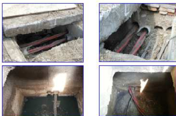
Tubazioni in cemento - amianto
